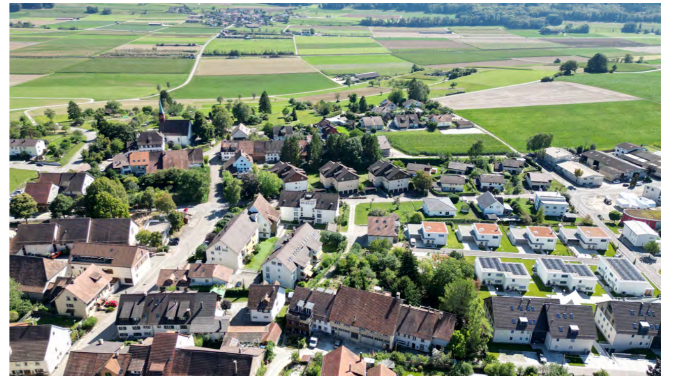
Abb. 3: Löhningen Blickrichtung Süden (inexo)
